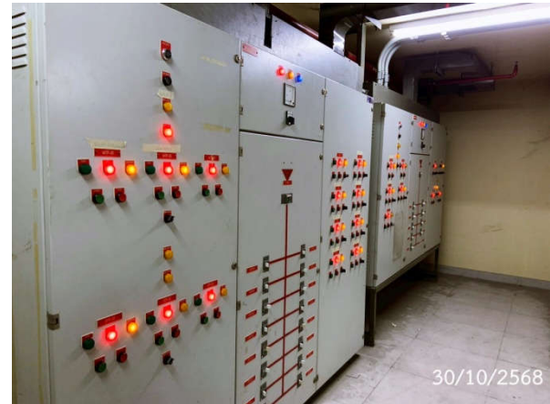
รูปที่ 2-10 ระบบบำบัดและควบคุมระบบบำบัดน้ำเสีย
