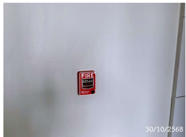
เครื่องแจ้งเหตุโดยใช่มือดึง (Manual Pull Station)
