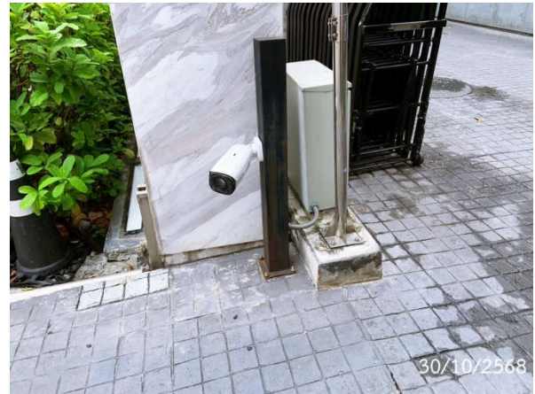
รูปที่ 2-50 กล้องวงจรปิด (CCTV)
