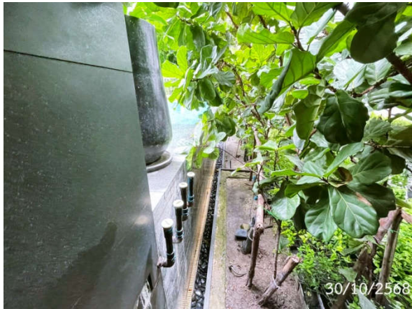
รูปที่ 2-44 รางระบายน้ำล้นรอบสระว่ายน้ำ
